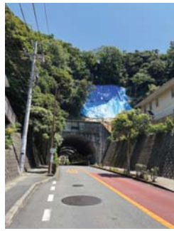
市役所通りトンネル
